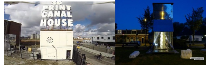
그림 3. Dus Architects 3D 프린팅 빌딩 'Canal house'
