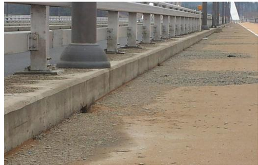
사진 1. 제설제에 노출된 콘크리트 표면 열화
