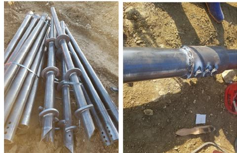
그림 1. 시험 파일과 이음부(핀+용접)
