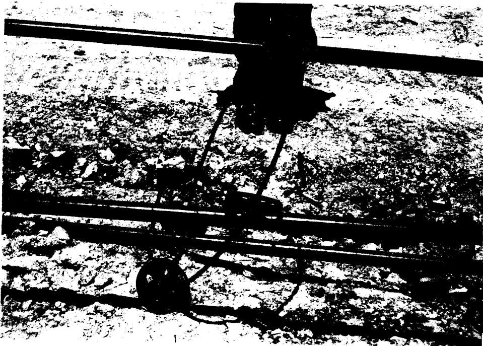
사진 3.2 수평검측기법 시험용 케이싱 고정장치
