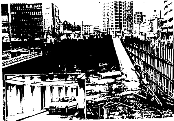
그림 15 Oslo City 빌딩 주차장 공사
