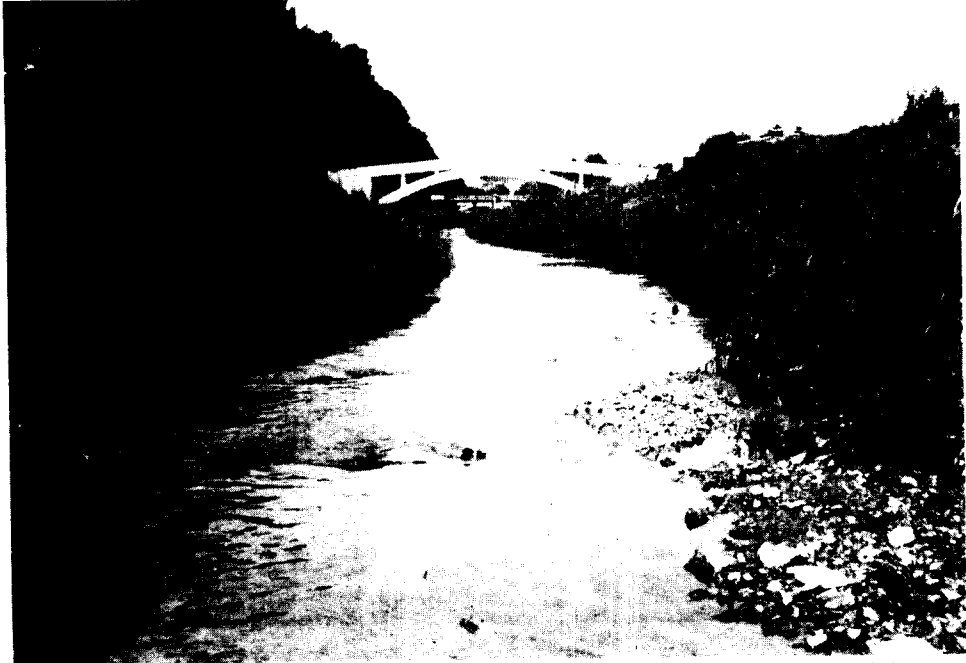
그림5 여의천 사행수로 조성으로 인한 퇴적과 침식이 진행되고 있음
