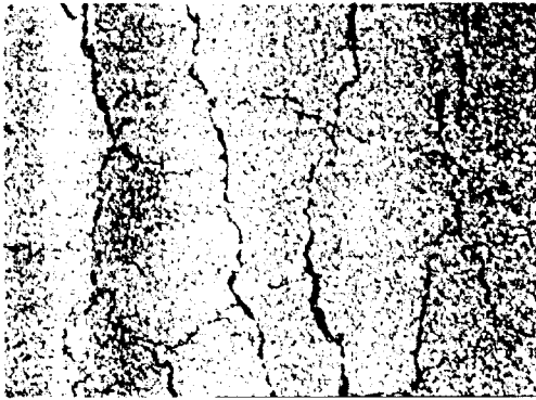
그림 6. 반복적인 Bending Stress로 인한 표면의 균열 (X75)
