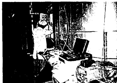
그림 8. 현장설치 작업 장면
