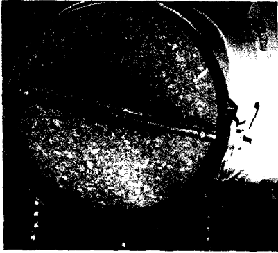
Photo 7 원형덕트 분기관 댐퍼의 날개가 닫혀있어 배압이 상승한 경우
