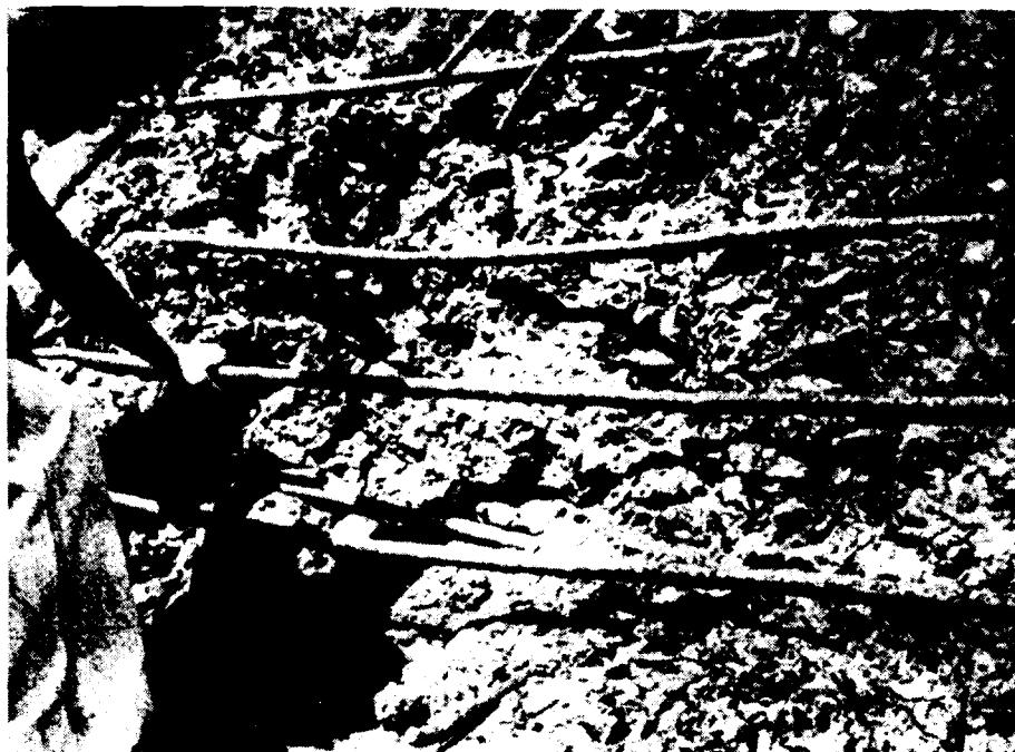
그림 1. 공동현상에 의한 콘크리트 구조물의 피해 사례
