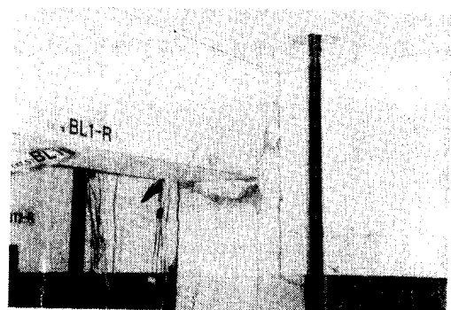
사진 3 최종 변위단계에서의 균열상황
