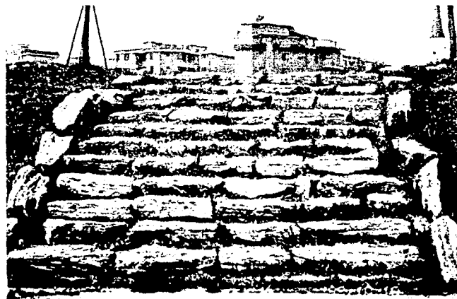
(b) 계단호안의 시공 예 (성내천 좌안)
