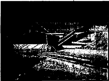
그림3. 정착길이 부족으로 인한 붕괴
