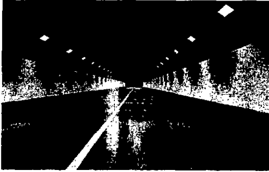
그림 1. 기존의 터널조명의 문제점 Fig. 1. A Problem of Tunnel Lighting at Present
