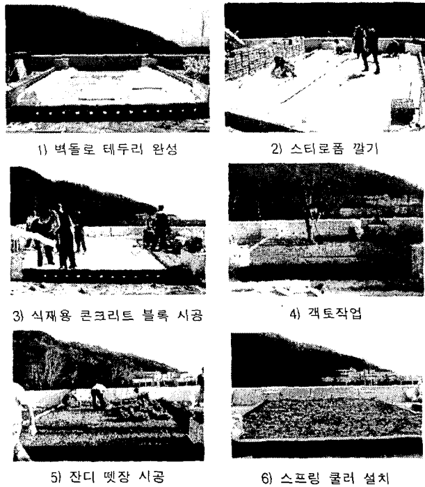
사진 1. 옥상식재용 콘크리트공법의 시공순서
