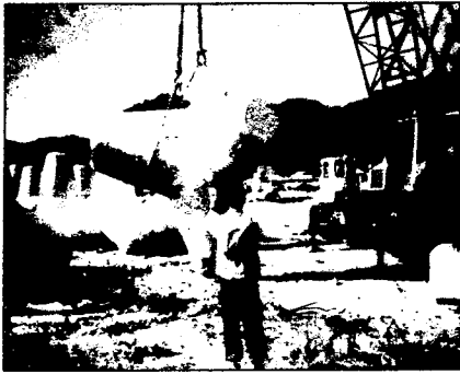
그림 8. Con'c Block위로 T.T.P의 이동모습
