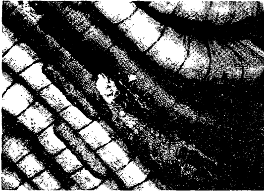
그림 2 절연사고 전동기 코일(엔드부) Fig. 2 Motor coil of the insulation accident (end part)
