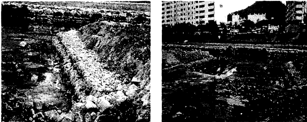
〈그림 7.11〉 연제구 관할의 온천천 우안에서의 돌망태공법 적용모습
