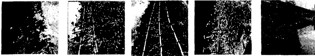
<그림 7.6> 저수로 호안공 - 윗가지 덮기 공법
