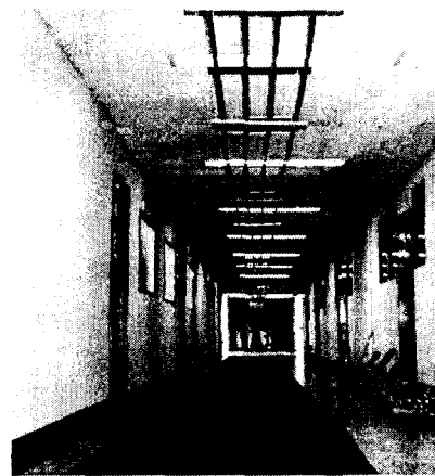
사진2. Air Sampling Pipe 설치
