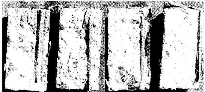
사진 4 균열시편의 내부 철근상태(12개월 침지)
