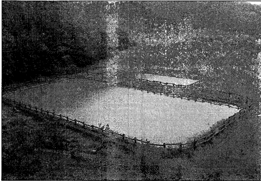
사진 1. 동해6갱 자연정화처리시설 전경 (갱내수->SAPS-침전조->호기성소택지->방류)
