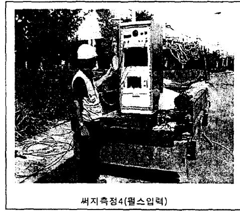
(그림10) 접지시스템의 서어지 전압 입력장면 (Fig10) Surge voltage input scene of ground connection system
