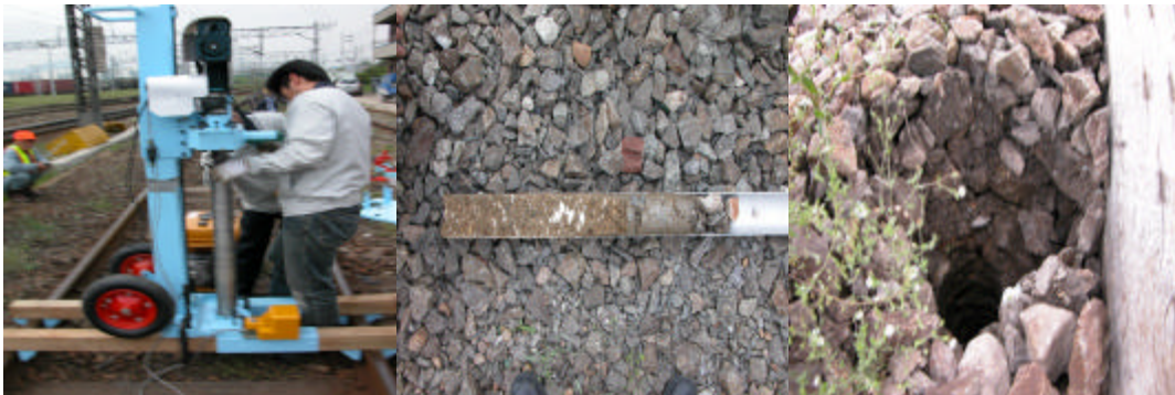
그림 7. PBS 시추 광경 그림 8. PBS로 시추한 샘플 그림 9. 시추 후 시추공 모습
