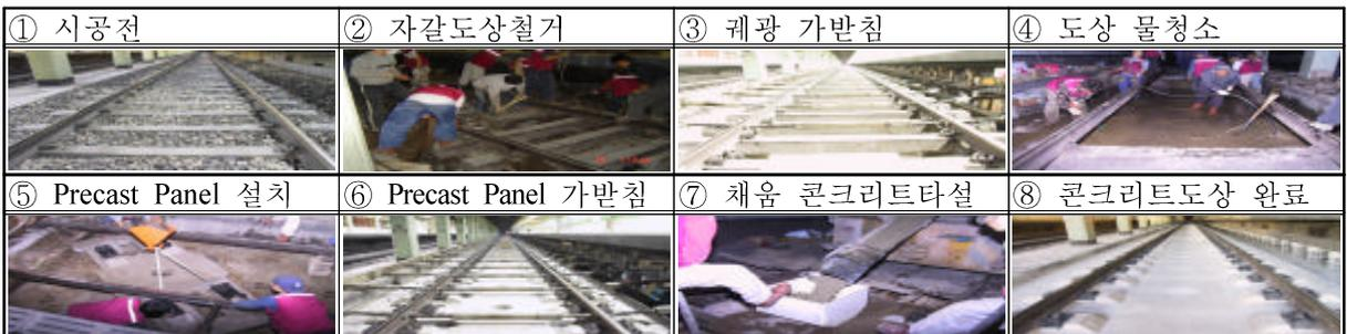
그림9. Precast Panel을 사용한 콘크리트도상화 시공순서
