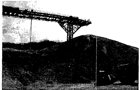
사진 1 부순 굵은골재 생산 전경 예
