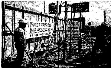
지하철 ○○공구 지반보강공사
