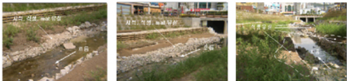
그림 5 고수부지에서의 사석, 식생, 식생mat 유실
