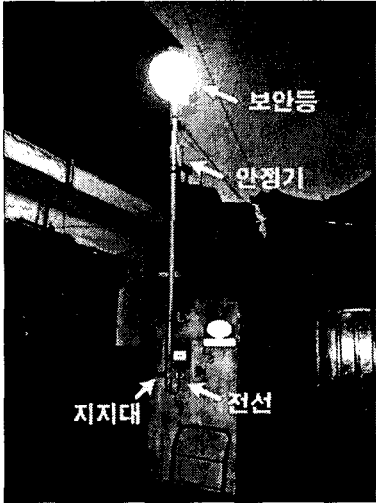
그림 7. 구조물에 부착하여 시설된 보안등 설비
