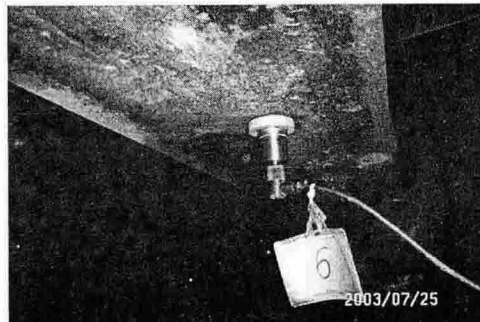
Fig. 6 가속도계 설치 사진 (복공판보)
