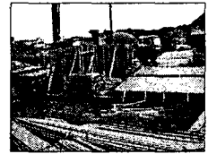
④ 콘크리트 타설
