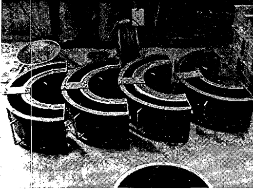
그림 3. 콘크리트 라이닝 모형 강재 거푸집
