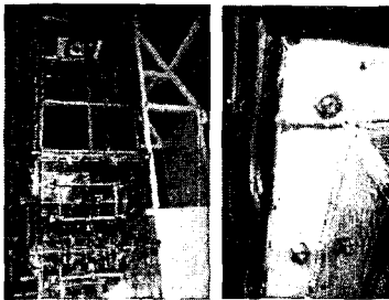
Mylar Film 적용 및 체결부 처리된 처리
