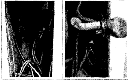
그림1. 누설위험이 높은 가로등주의 결선상태 fig 1. A street lamp pole in dangerous state
