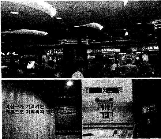
그림 6. 조사대상지의 비상조명 실태 Fig. 6. The actual condition of target area
