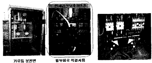
그림 23 누전차단기를 직결사용한 사례 Fig 23 The example which connected the elb directly
