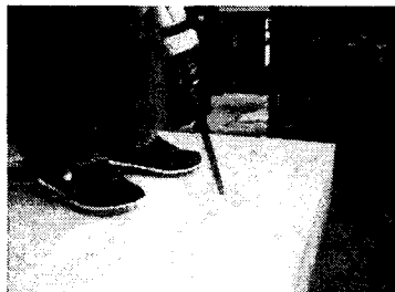
그림 2. 인력 브레이커에 의한 표면처리
