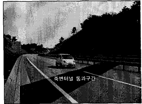
그림 2. 도로하부 통과구간 상부 전경
