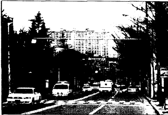
<그림 2> 횡단보도 조명시설(A Type)
