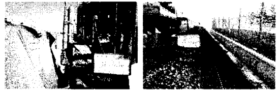
(그림2-10) XIT 서지저감 접지봉 설치
