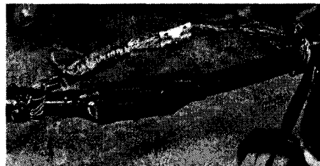
(b) 23[kV]급 케이블 중간 접속
