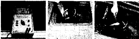
그림 11 실제 누전전압 및 전류측정 사례
