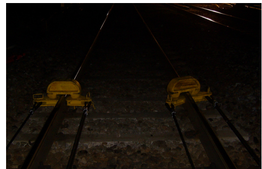
그림 2 레일 긴장기를 이용한 재설정
