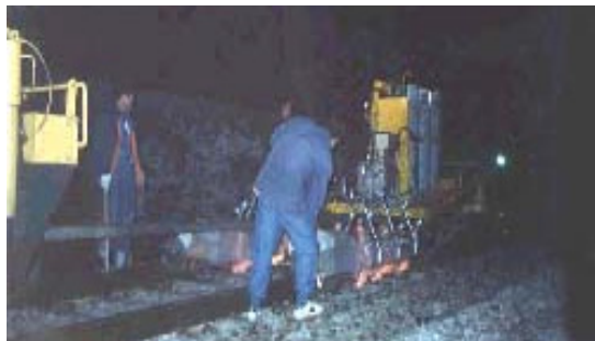
그림 1 레일 가열기를 이용한 재설정
