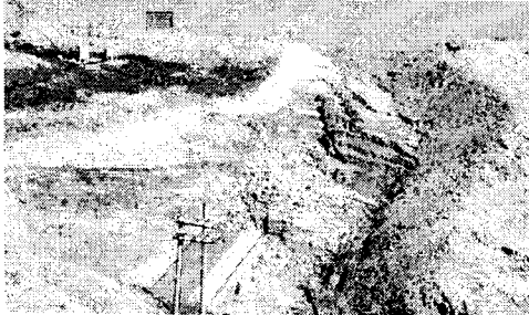
그림 5. 발전댐 담수부 : 층리면 따른 평면파괴
