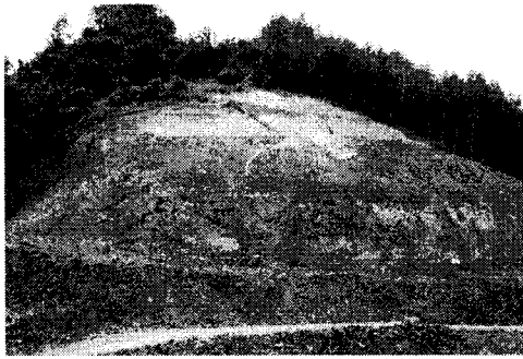
그림 1. 굴착중 사면 전반 붕괴 발생
