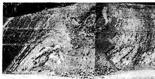
그림 8. “M” type 습곡 측부에서의 붕괴
