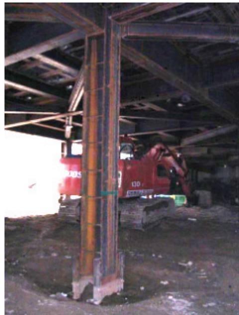
사진 2. H형강 선기초기둥이 굴토 후 드러난 모습
