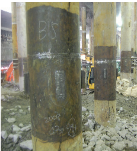
사진 3. 원형 CFT 선기초기둥이 굴토 후 드러난 모습
