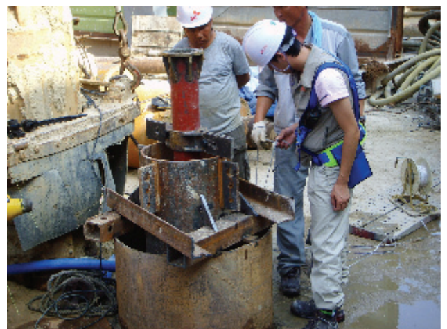
사진 4. 원형 CFT 콘크리트 타설 모습
