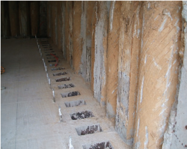
그림 4. 개방형 슬래브로 시공한 모습
