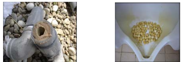
Fig. 1 기존 소변기의 문제점 사진.
