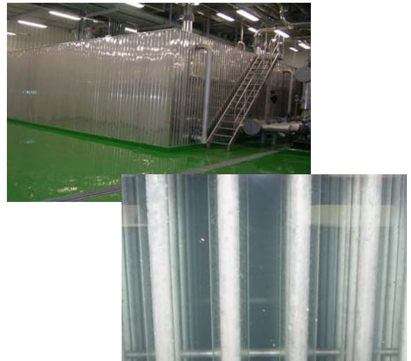
Fig. 6 아이스빌더 및 코일 축냉 상태
