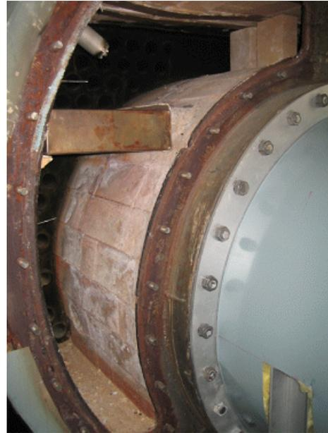
Fig. 6 2-pass와 3-pass 사이에 설치된 DeNOx 촉매
