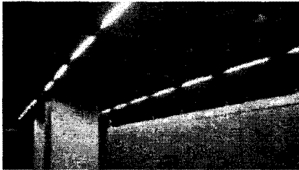
그림 4. 변전실에 설치된 라이트웨이(예)
