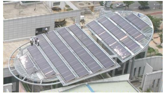
그림 2. 진공관형 집열기 설치 전경
